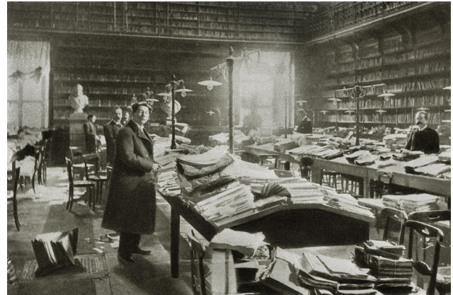
Fig. 14: Torino - Biblioteca nazionale. Si valutano i danni dopo l'incendio del 27 gennaio (1904) (Fototeca Gilardi).
