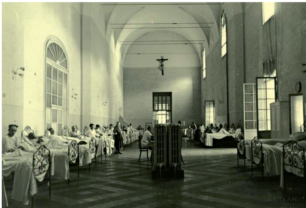
Veduta dell'interno della sezione medica maschile "Alzona", Ospedale Maggiore, 1930, fotografia di A. Villani, Archivio fotografica dell'Azienda unità sanitaria locale di Bologna
