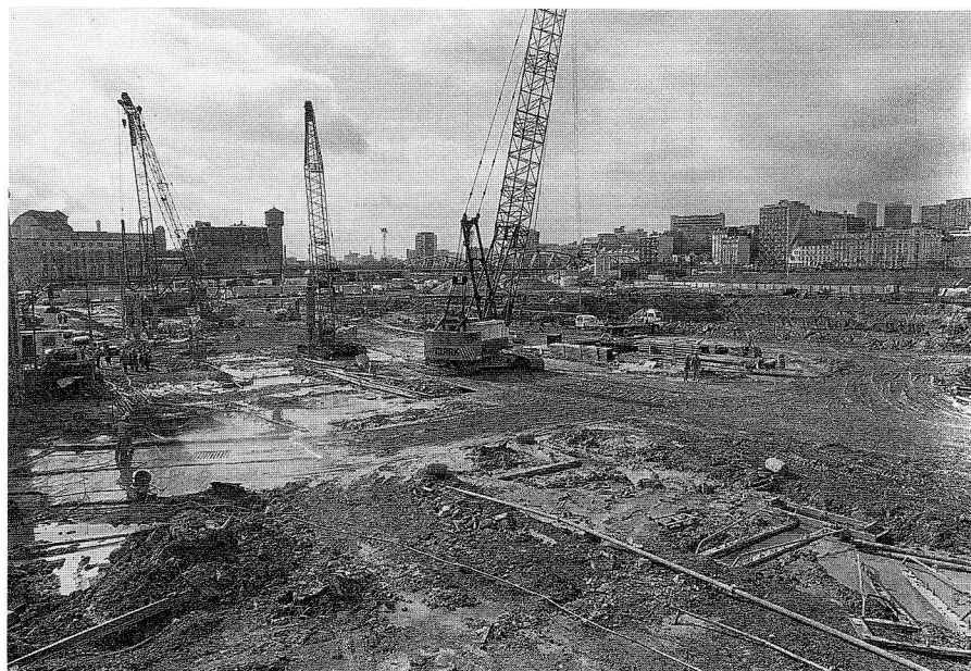
Il cantiere della Bibliothèque de France nel marzo del 1991
